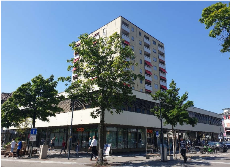
Gebäudeansicht von Südost mit Läden und Poststelle
