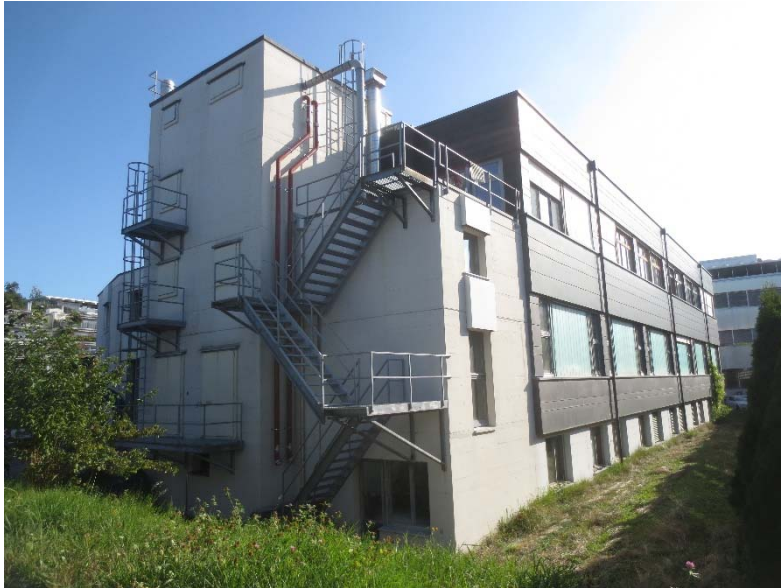
Aussenansicht von West auf den Schnitzelbunker mit Treppenaufgang
