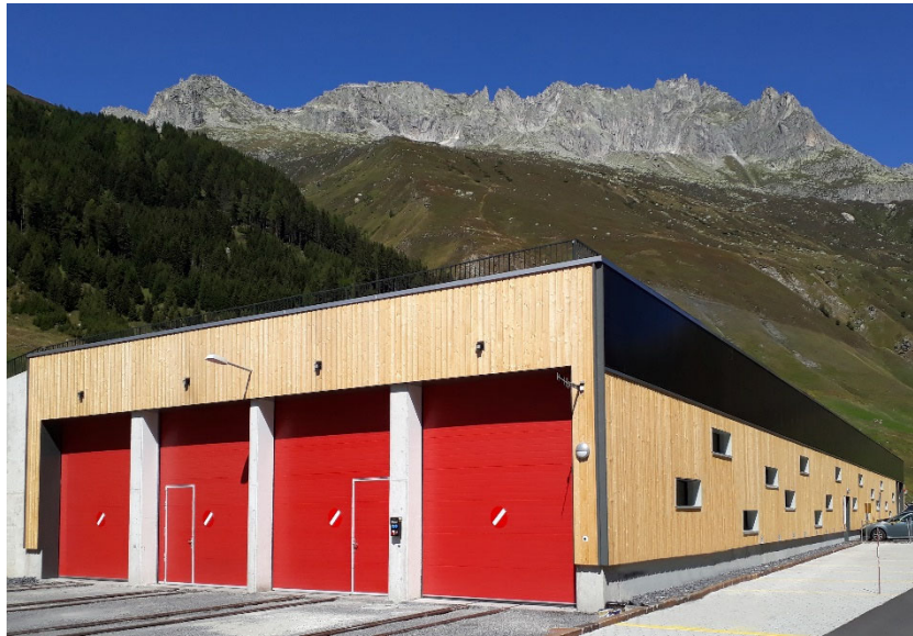
Wagenremise mit PVA, Quelle: Bauplanung Suter GmbH
