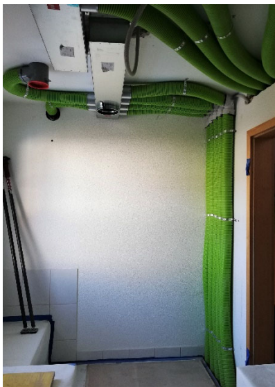
Bild 1: Lüftungsleitungen während dem Einbau
