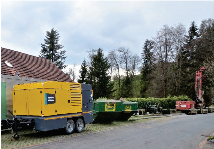
Erdsondenbohrung auf Besucherparkplätzen
