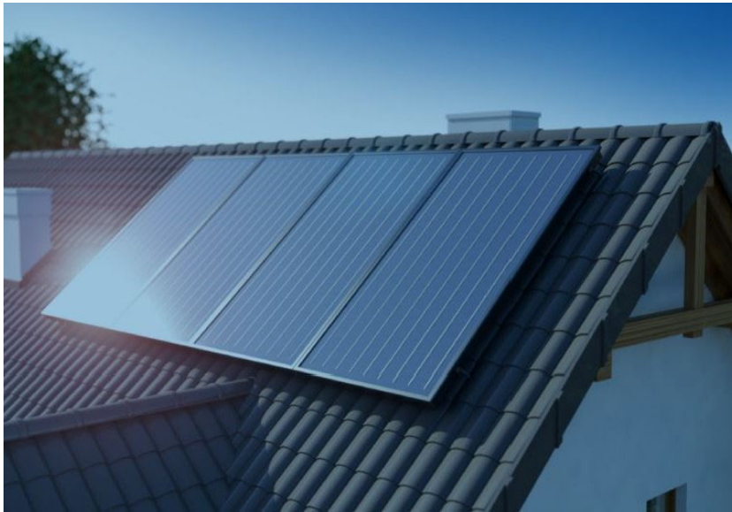
Aufdach-Solaranlage. Quelle: Forschungsbericht SolThermGo
