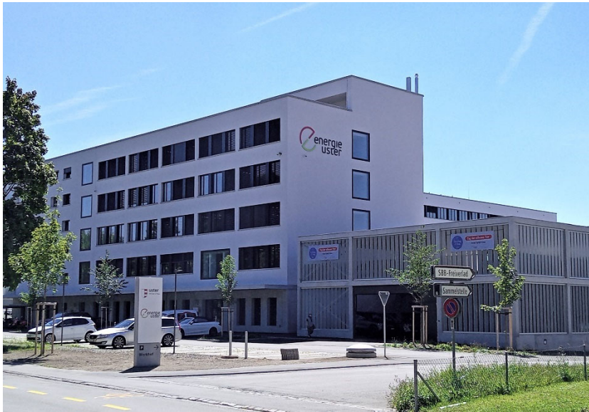
Verwaltungsbau Energie Uster AG und Wohnungsteil (ganz links), nach Minergie-Sanierung bzw. Umbau
