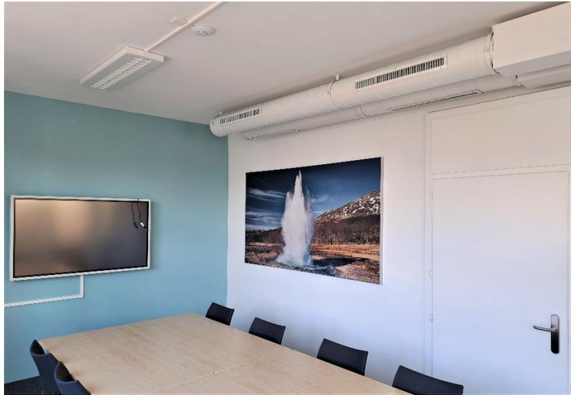
Sitzungszimmer mit Lüftungsleitungen an Decke (Sichtmontage)
