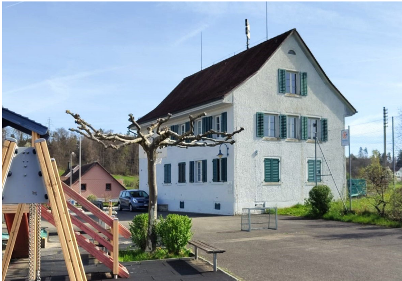
Schulhaus Oberdorfstrasse in Sulzbach
