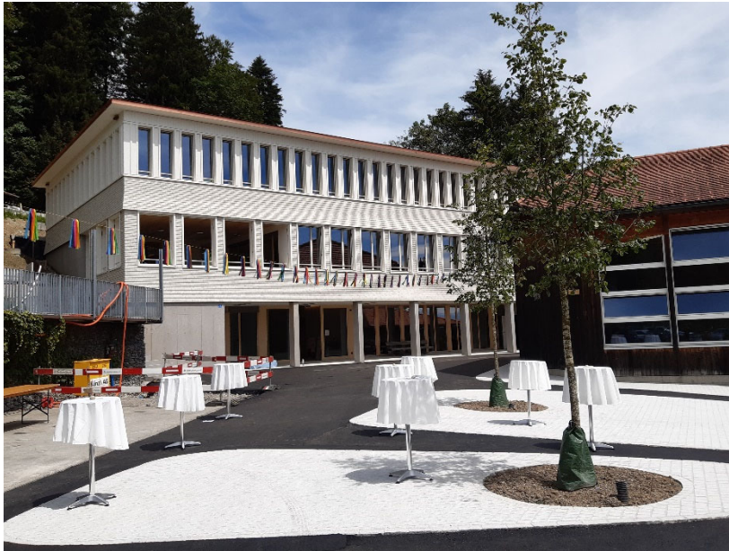
St. Michael TP1 Ansicht Haus
