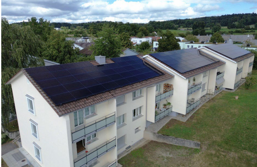
Sanierte Fassaden, Geissbergstrasse 14/16/18 Kloten
